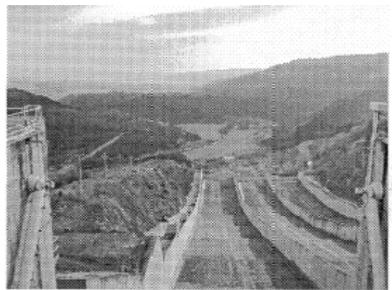
サンロケダム洪水吐きから下流を望む
