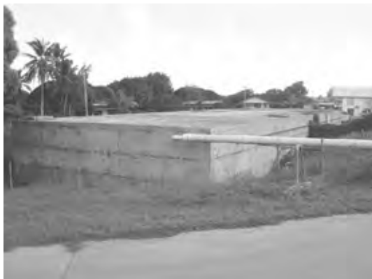
既設雨水貯留槽 外観
