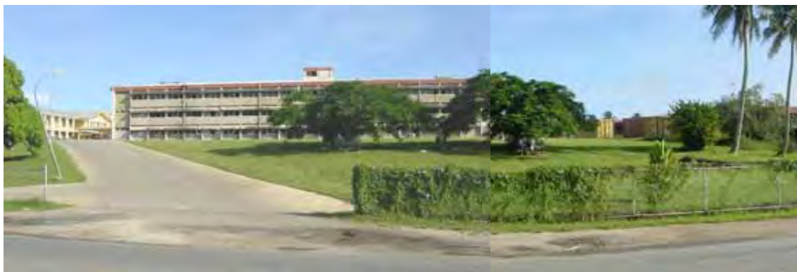
救急・外来棟と前面駐車場建設予定地（正面建物は旧病棟で「ト」国側にて解体予定）
