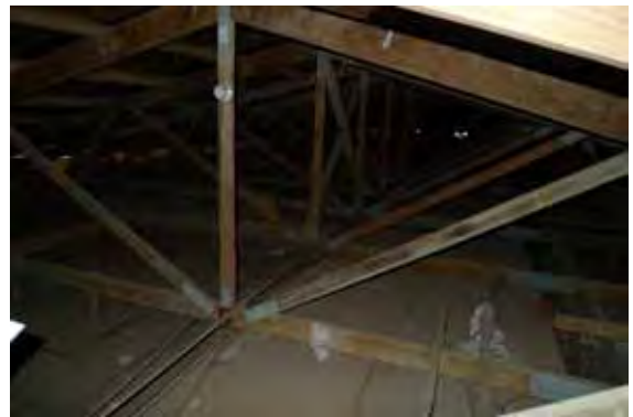
旧検査棟屋根裏 小屋組みは再利用可能な状態
