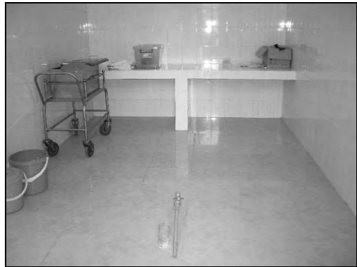
生検解剖部門 (別棟1階) H棟横に新築された建物である。解剖台 設置のために給水と排水が準備されて いる。
