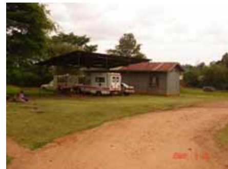
建設予定地 既存の仮設車庫とコミュニティ棟を解体後、本計画建物を建設する。
