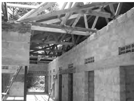
マサカ地域中核病院内建設現場
