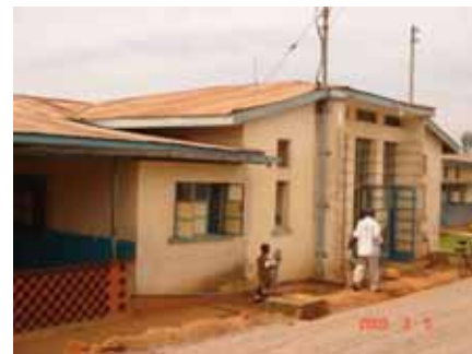
外来棟 1956年に建設され、救急、ラボが付属している。
