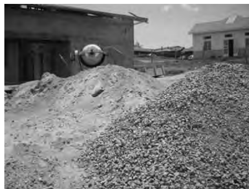
現場ミキシング 骨材保管状況
