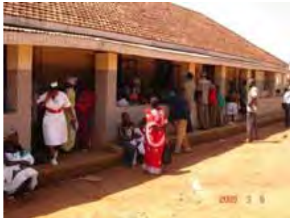
外来・管理棟 1930年代に建設され、全体的に狭く、老朽化が激しい。診察待ちの患者で込み合っている。
