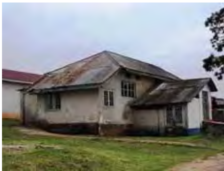
小手術棟 1920年代に建設され、屋根、外壁等の老朽化が激しい。現在は使用されていない。
