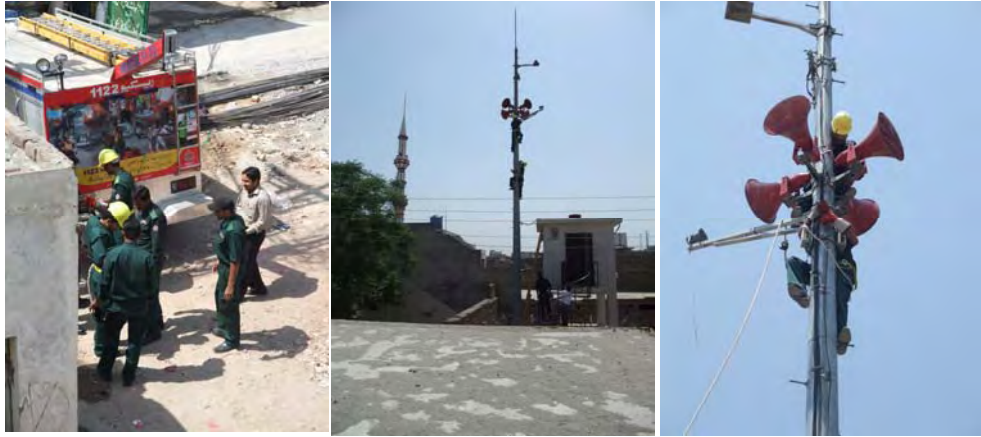
図 4-3 警報局 WP-2 スピーカー配線修理
