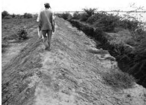
写真 4-30 堤防 (堤防のすぐ横の溝から盛土している)
