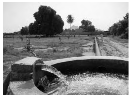
写真4-29 ポンプ灌漑 (貯水槽と導水のためのパイプライン)
