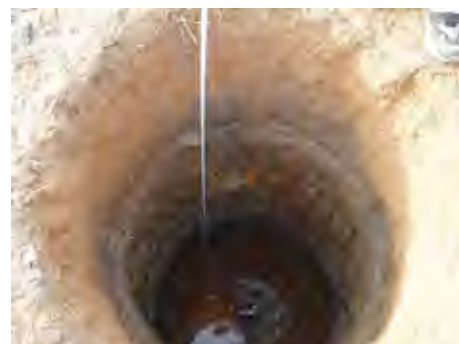
図 2-8 掘削後の状況 (BH-①)
