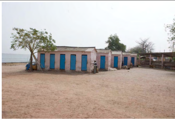
カシュー水産センター漁具倉庫：本計画施設設計の上で参考とする漁具倉庫。
