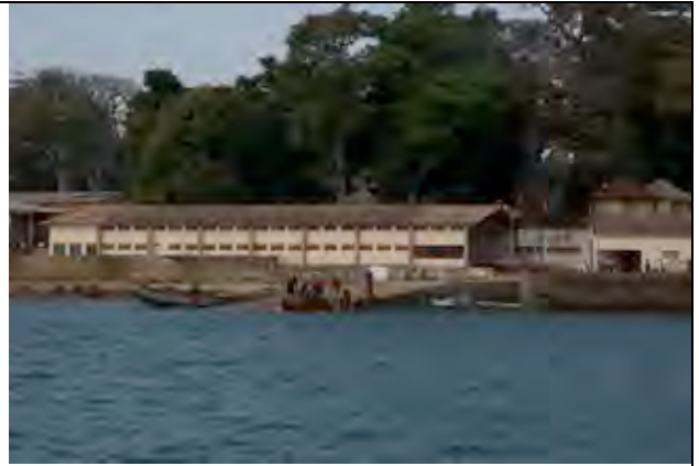
ボラマ漁港の斜路：干満両時間帯でも漁船が利用できるような水揚施設は斜路の形状が多く採用されている。
