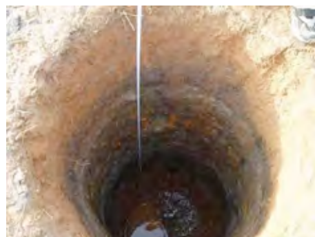
図 2-8 掘削後の状況 (BH-①)
