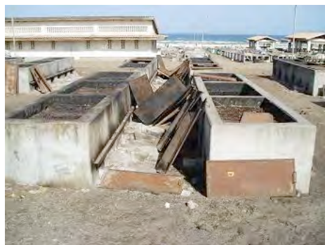
燻製カマド（セネガル国カイヤール）
