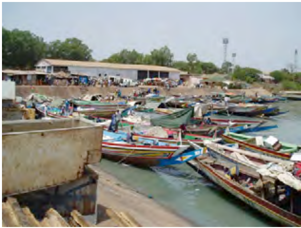
ビスウ漁港の係留状況：ビスウの零細漁港では漁船が係留する両側が階段式の斜路が採用されている。
