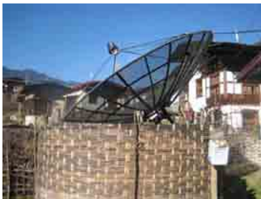
トンサ県 Rukubji 村に BBS と BICMA (放送 の規制官庁) の共同パイロットプロジェ クトの一環で設置された衛星放送受信 アンテナ
