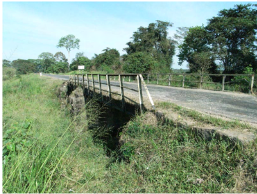
写真-1 : なだらかで見通しの良い区間に架設されている。
