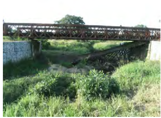
写真-14 : ベイリー橋はギャビオンの上に載っている。河川内に LTTE により爆破され落橋したトラス橋が残っており、通水断面を阻害している。
