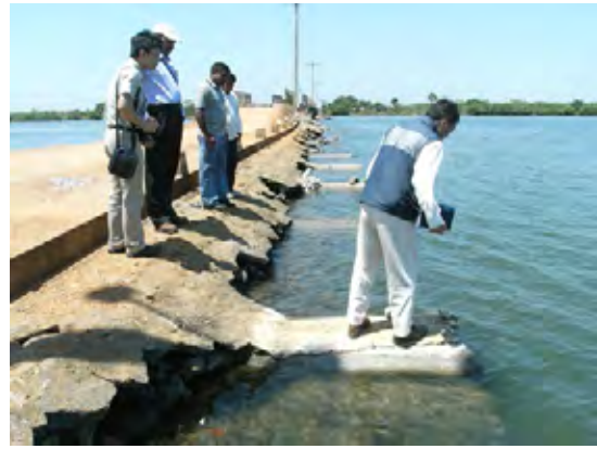
写真-26 : 水深は浅いが、橋梁部の水流は早い。 コーズウェイにはパイプカルバート φ1.5m が設置されている。
