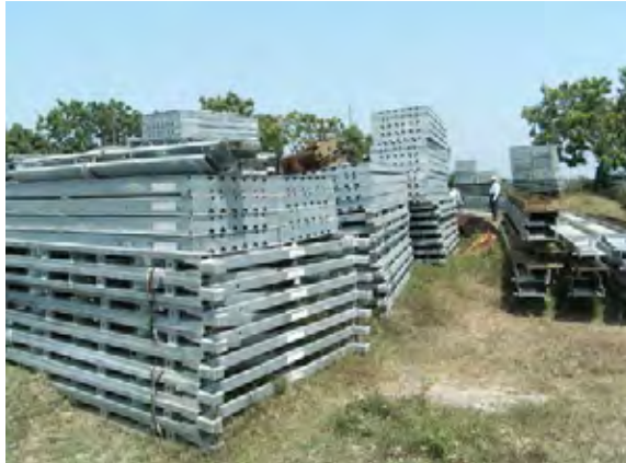
写真-32 : パニチャンケニ橋の迂回路用のベイリー橋。バテイカロアの RDA デポにて。
