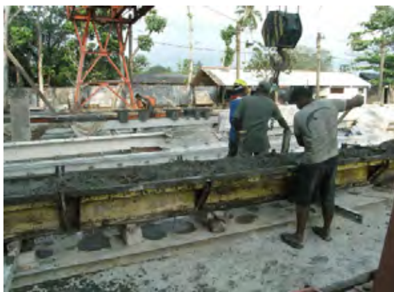
写真-33 : プレテン工場の桁製作状況。採用する場合には、コンクリートの品質管理について、日本人技術者の協力が望ましい。
