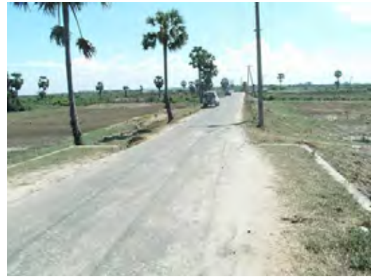
写真-20 : 起点マハ・オヤ側望む。画面右方向（北側）にカーブし、短いカルバートが連なる。ADB 道路改良計画が進行中である。
