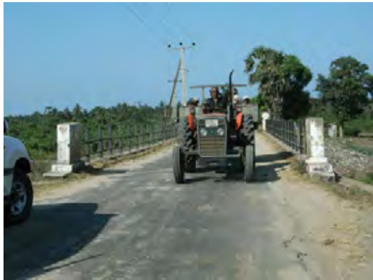
写真-19 : 終点チェンカラディ方向を望む。A5 号線の東側終点 A15 号線との交差点近く。 橋梁幅員は 1 車線。
