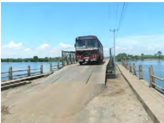
写真-29 : ベイリー橋とコーズウェイとの接合部。仮設の板が置かれているだけのため、徐行での通行となる。 橋梁幅員は1車線。
