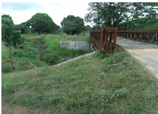
写真-17 : 急なカーブ区間に架設されている。
