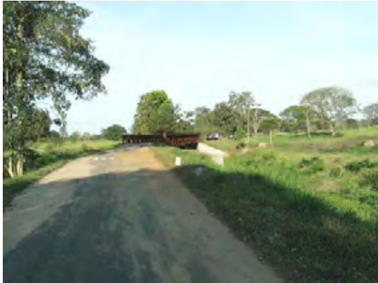
写真-13 : 道路が南にゆるくカーブした箇所にベイリー橋が架設されている。南側（写真右側）に道路に平行して高圧線がある。
