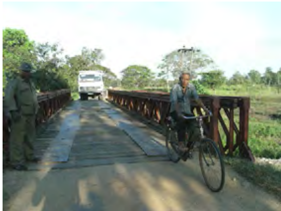
写真-15 : 橋面は木製で、橋梁幅員は1車線
