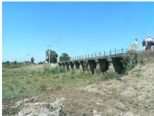
写真-21 : 氾濫現の中の橋梁であるが、雨期以外は河川に流水がない。
