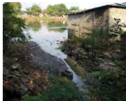
図 2-11 Mesurado 川に流出する中継ポンプ場からの下水
