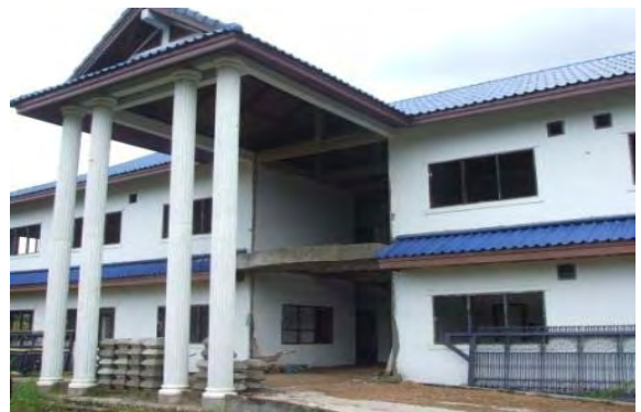
PIPプロジェクト（サラワン県司法局庁舎建設）
