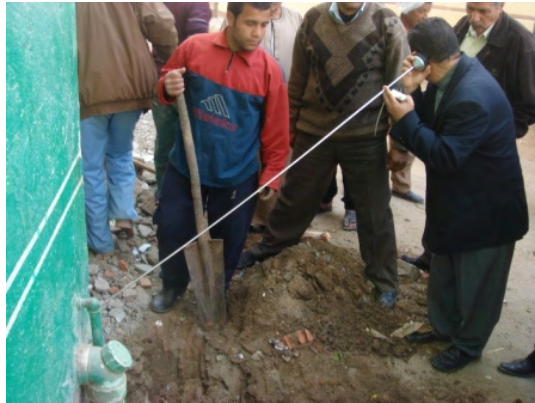
音聴棒：左探知機を用いて漏水の可能性が疑われた給水管からの漏水音を聞き取る様子。
