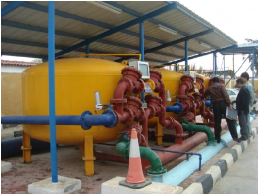
ろ過機：SOP 活動対象施設であり、浄水過程における水質変化（特に残留塩素濃度）を測定している。
