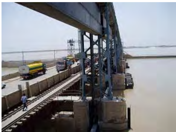
インダス河 Taunsa 堰無償資金協力現場
