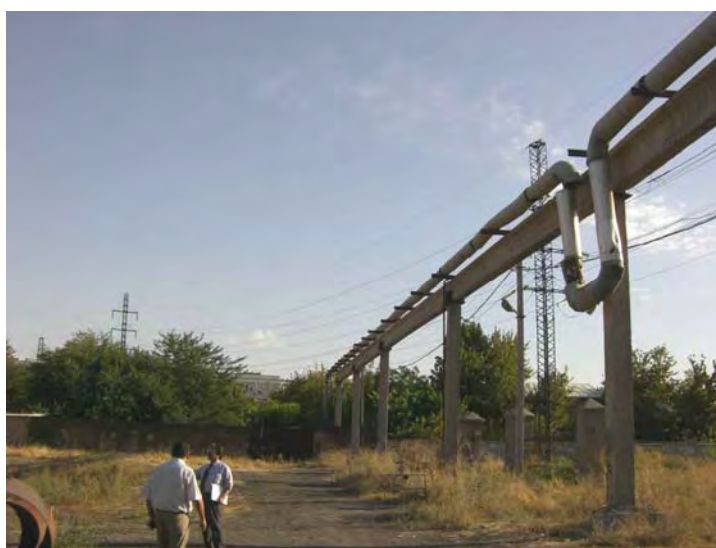
Рис.1-2-3 Паровой трубопровод
