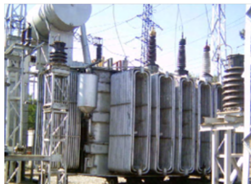
Рис. 2-1-5 Повышающий трансформатор
