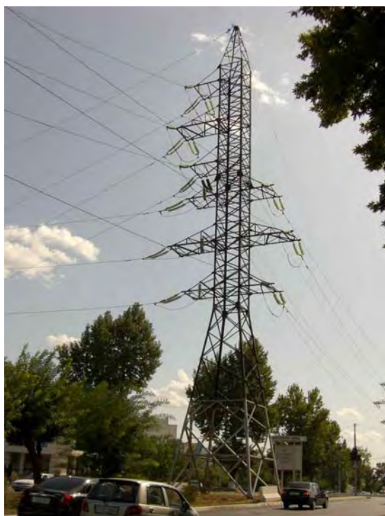
Рис. 1-2-7 Форма стандартной разветвительной опоры
