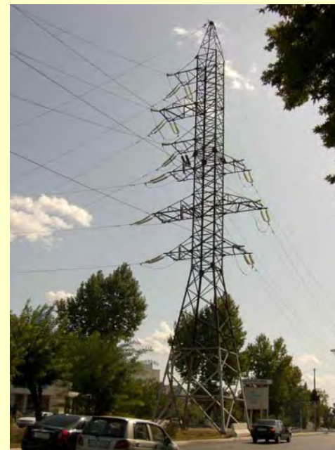
Стандартная опора для Т-образного ответвления
