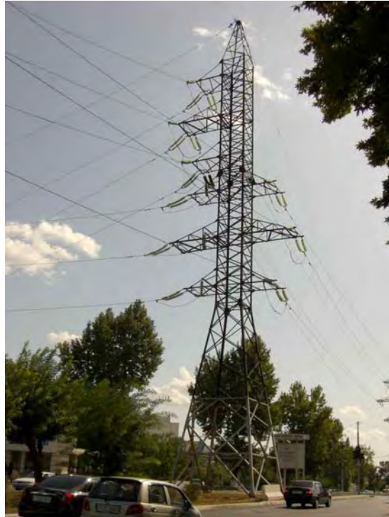
図 1-2-7 標準的に用いられている分岐鉄塔の形状
