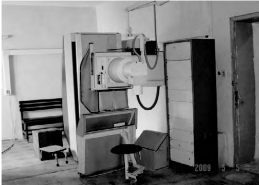
古い透視撮影用X線装置 （右側のドアは木製、放射線漏洩防止対策がされていない）
