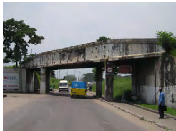
PK2+900 のプロジェクト道路を跨ぐ鉄道橋： 建築限界が 4m で車高の高い大型車の通行は制限される。
