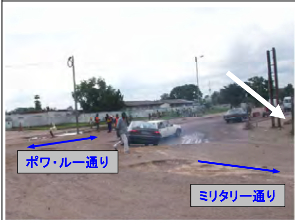
ナバル交差点： 路床が露出し走行が非常に困難な箇所である。
