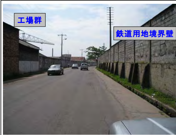
PK1+000 付近の道路占有狭小部： 限定 2 車線区間で計画路肩幅が 50cm しか取れない。
