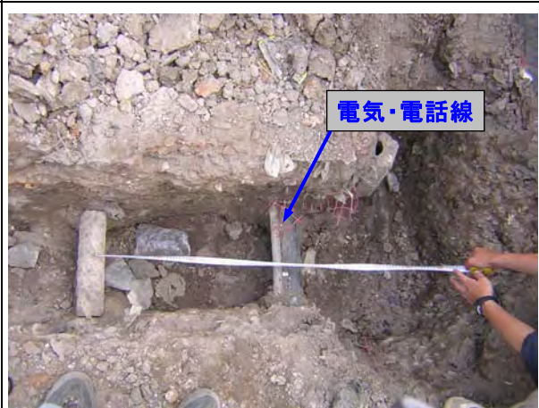
地下埋設支障物件： PK2+250 付近に埋設されていて工事の支障となる電気・電話線埋設状況。
