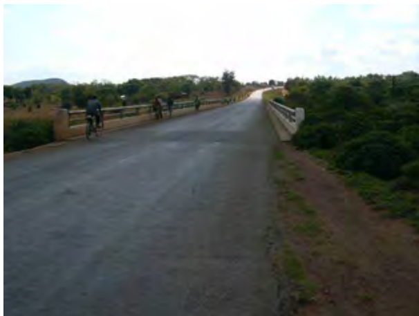
マラウイ共和国の主要幹線道路であるM-1道路（市の最南部 Area 38）
