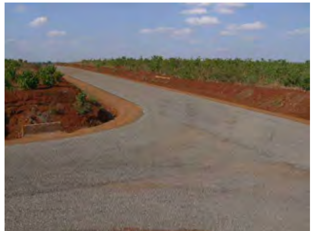
植林が行われていた場所に新たに開発中の住宅地区（Area 43）
