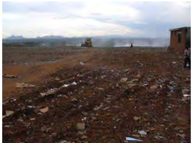
投棄された後に重機による締め固めが行わ れている廃棄物処分場 (Area 38)
