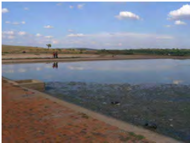
日本の無償資金協力により建設された酸化池 方式による排水処理場 (Area 43)
