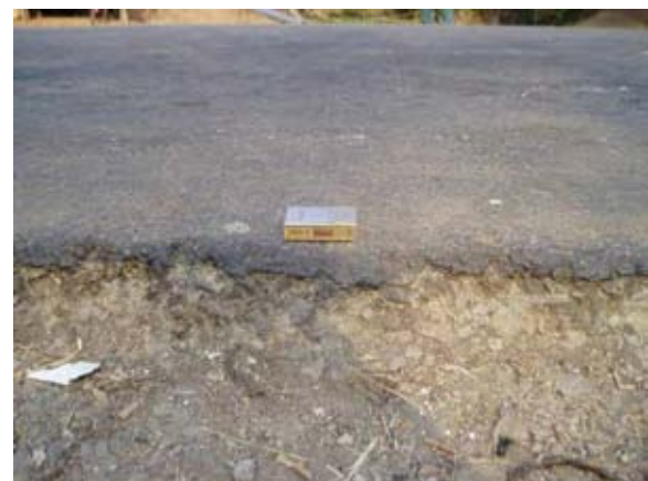
写真 2 - 4 橋梁付近道路の舗装構成 薄い舗装厚が破損している。
