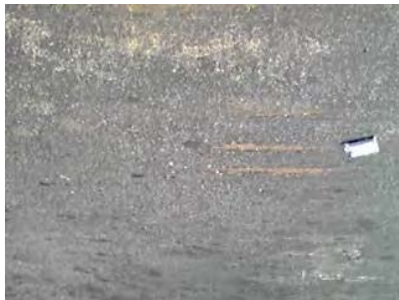
写真 2 - 3 橋梁手前の路面損傷が放置されたままになっている。
