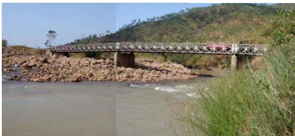
南ルクル川の上流方向からルクル橋を望む。写真左奥からルラ川が流れ込む。ルラ川の河床は高く、国道1号との高低差が小さいため、洪水時は橋北側(写真左側)の取り付け道路まで冠水(越流)する。
