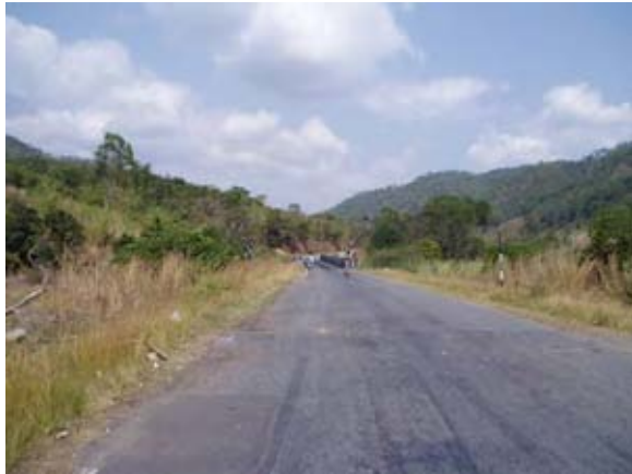
写真 2 - 1 橋梁手前にある速度制限のために設けたハンプ
