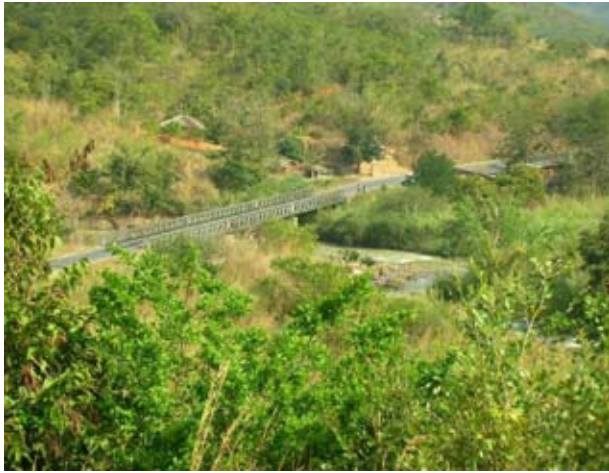
既存ルクル橋全景（上流左岸高台より）
