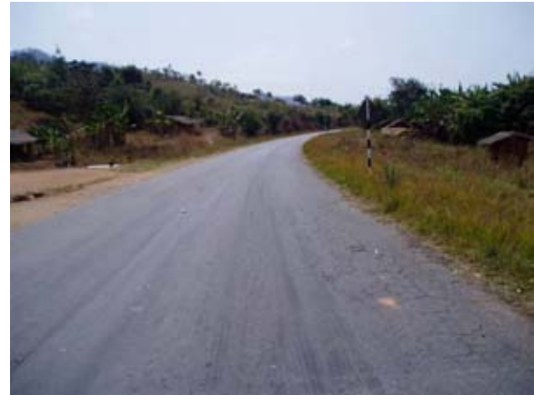
写真 2 - 2 橋梁北部手前の1号線、道路右側にクラックが目立つ。
