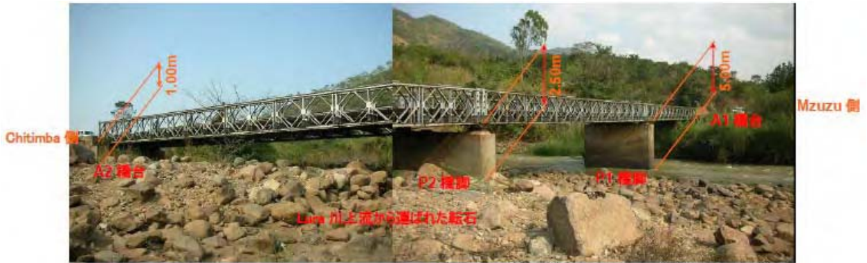
ルクル橋全景（上流側）
