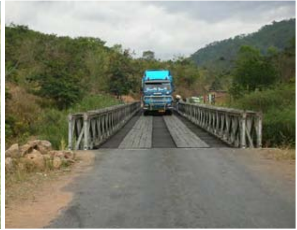
床版状況及びルクル橋を通過する重車両
