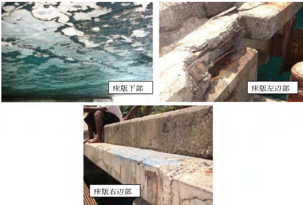
写真 2-1-4(1) 既設棧橋床版の代表的なひび割れ発生状況
