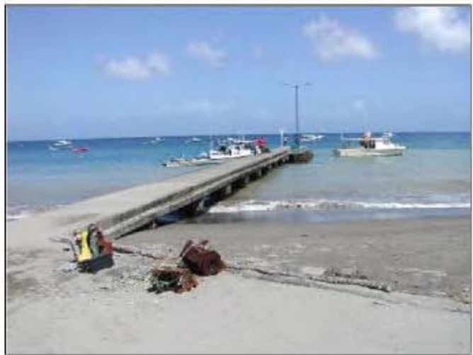
写真—6 既存棧橋 (水産物の水揚げ等が行なわれているが、棧橋幅は4m程度しかない。また、水揚げが可能なのは先端の約20m部分のみである。)
