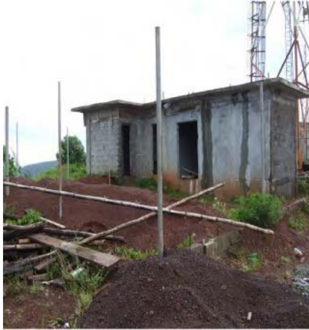
写真—3 1 アンテナ鉄塔予定地 (幹線道路から 400m程山間部に入った地点に位置している。)
