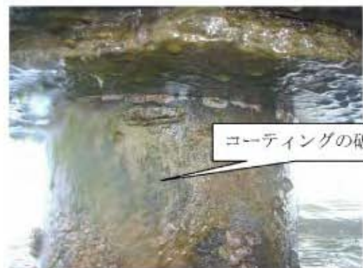
写真-29 既設栈橋床版の代表的なひび割れ発生状況
