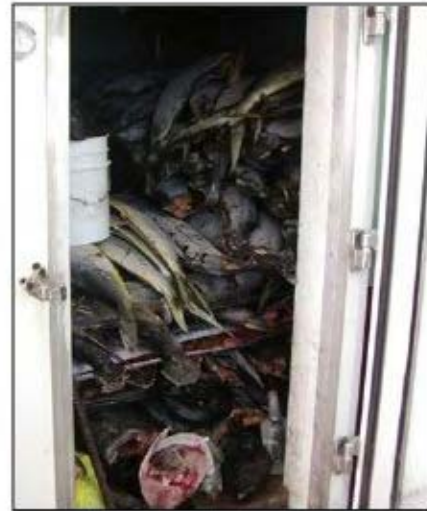
写真—26 冷凍庫内状況 （機能が低下しており、結露が生じている。）
