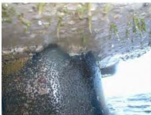
写真-29 既設栈橋床版の代表的なひび割れ発生状況
