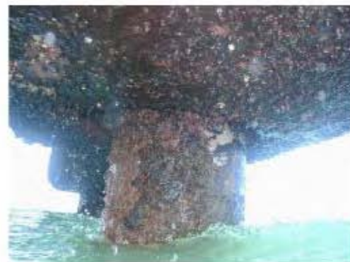
写真-30 既設鋼管杭 杭頭部の状況 (腐食が進み耐用年数を待たずに応力対応が困難な状況に至る。)
