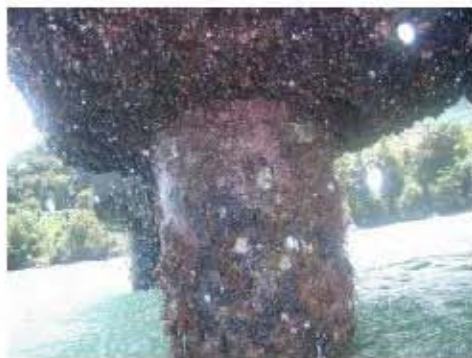
写真-30 既設鋼管杭 杭頭部の状況 (腐食が進み耐用年数を待たずに応力対応が困難な状況に至る。)
