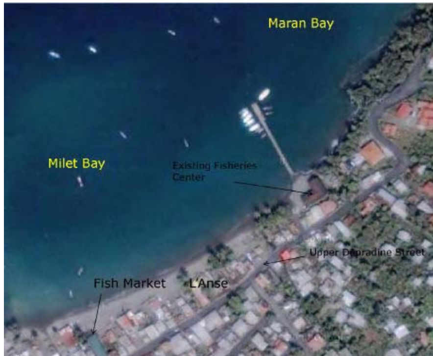
図 1-1-1(7) 既存水産センターと魚市場
