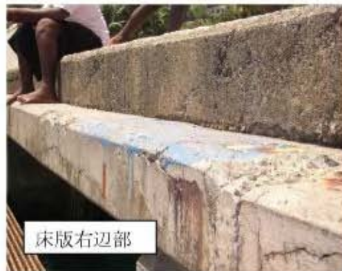
写真-29 既設栈橋床版の代表的なひび割れ発生状況
