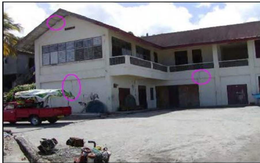
写真—3 既存水産センター
