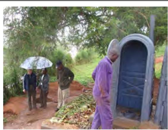
同時に設置したエコサントイレ。尿は分離され左の穴へ落ちる仕組み。紫色の人物は販売元の設置技術者。
