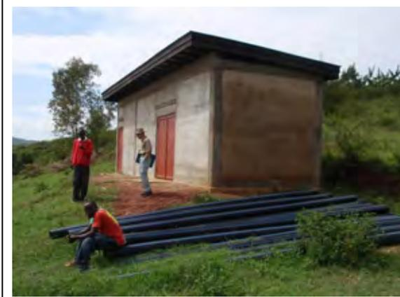
MKM スキームのルワキボゴ水源にある、スペアパーツを保管する倉庫。野積みの P 管が日光で変形している。
