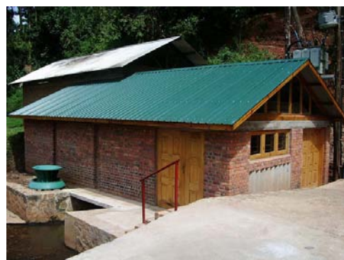
新発電所 2009年2月完成
