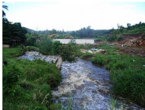
放流水とブゴエ発電所の取水工
