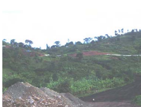
等高線沿いの導水路
