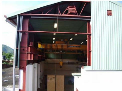
発電所(13 MW=2×6.5 MW)
