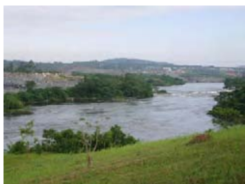
2011年完成予定の建設工事(右岸から撮影)
