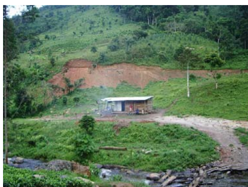
水路と発電所建設現場
