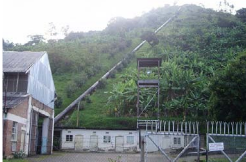
鉄管路と発電所(キレンベ鉱山所有)
