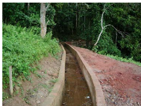
導水路(0.8 m 幅・1 m 深さ)
