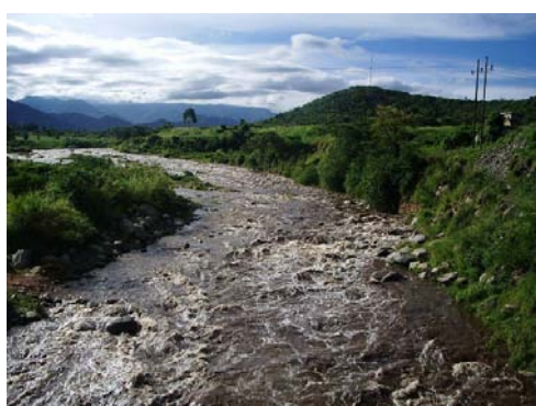
上流に2 既設発電所と建設中の1 発電所あり
