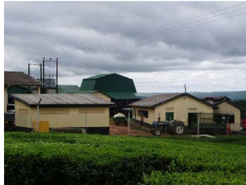
バイオマスガス化発電(205 kW 2006 年～)
