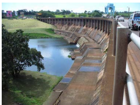
オーエンフォール発電所上流
