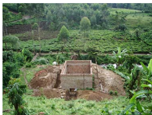
発電所建設中(落差約 40 m・60 kW)
