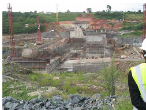
発電所建設中(5×5万kW・MEMD 写真提供)
