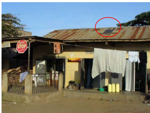
充電用太陽光発電パネル
