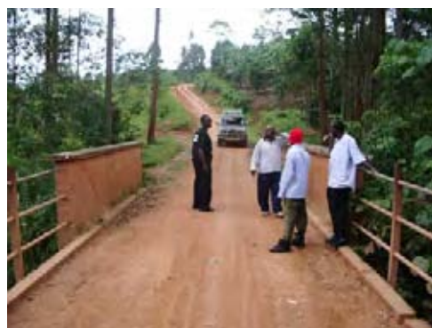
ニチウエラ川道路橋
