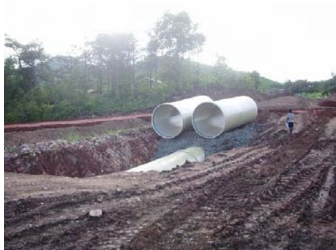
水圧管路(流量 10\text{m}^3/\text{sec} , 落差 160 m)
