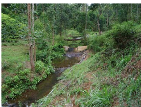
小水力発電の取水堰と導水管 (PVC 150mm)
