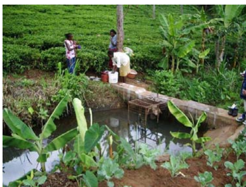
幅 2 m 程度の小川をせき止めた取水堰
