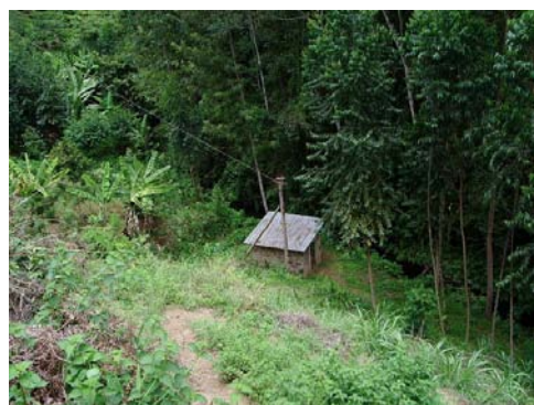
約 50 m 下の発電所
