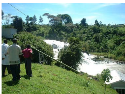
水圧鉄管路と発電所
