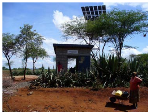
給水小屋・太陽光発電パネルと給水タンク
