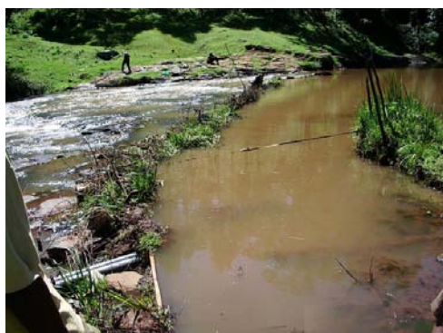
チェモシット川堰と取水口 PVC管(径 150 mm)
