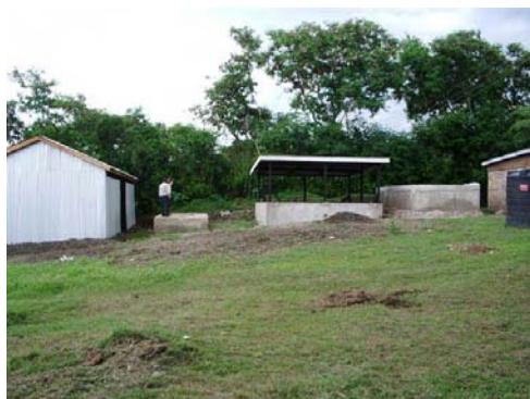
建設中のバイオガス装置(UNIDO・KIRDI 支援)
