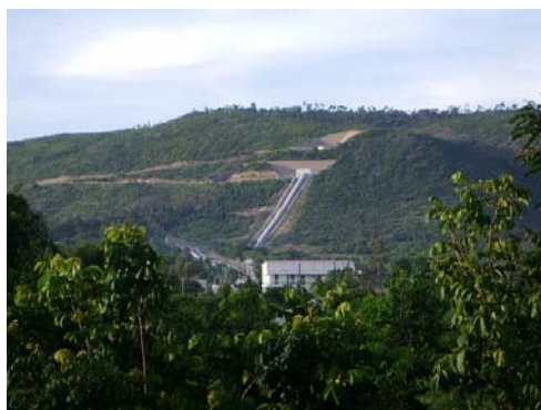
水圧鉄管路と発電所
