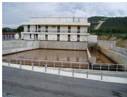
水力発電所(60 MW)
