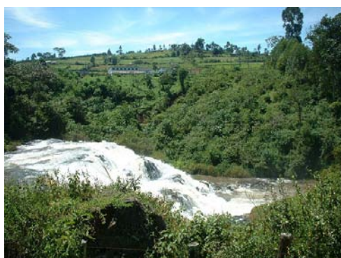
モゴゴセク工場の水力発電所で利用している滝
