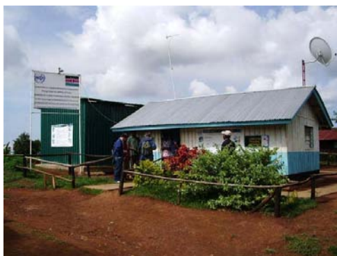
UNIDO 支援のキバエ Energy Kiosk
