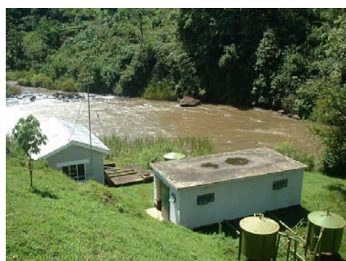
水力発電所(左)と揚水ポンプ場(右)
