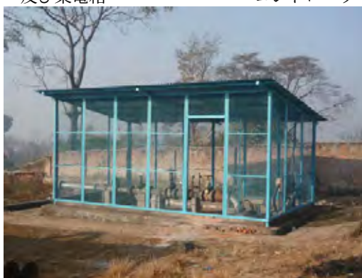
井戸ポンプ小屋
