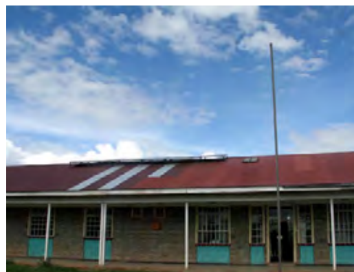
Secondary School (PV システム設置済み)
