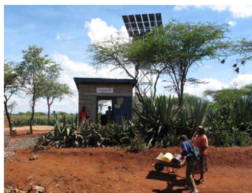
PV システムによる井戸(Grundfos 社による)
