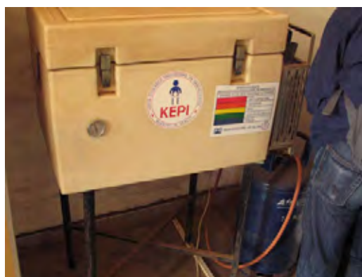
LPG または電気(12 V DC)により稼動する冷蔵庫 撮影: JICA 調査団
