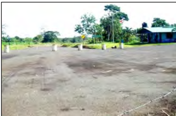
写真-11：ラストブリージャスにあるコスタリカ側の国境施設（写真右側）。「コ」国側は国境施設までの道路舗装を既に完了している。「ニ」国及び「コ」国は、サンタフェ橋完成時迄に国境施設を開設する予定である。
