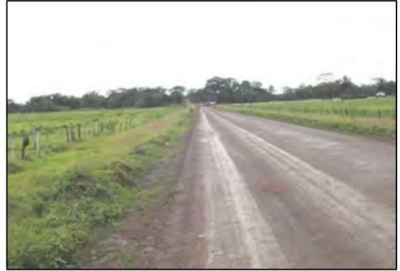
写真-8：船着場に向かうニカラグア側（左岸側）の現道。サンタフェ橋取付道路は、この現道の左側に沿って構築される。なお、現在は土道であるが、中米経済統合銀行（CABEI）の融資により整備される予定。
