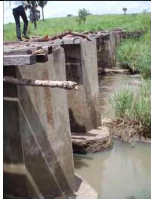
Aswa 川に架かる既存橋 (側面)
