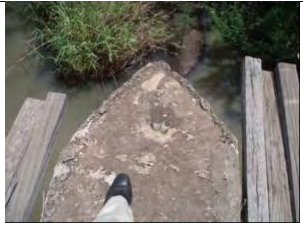
Aswa 川に架かる既存橋 (橋脚)
