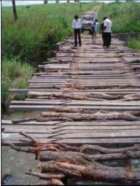
Aswa 川に架かる既存橋 (L=40m 弱)
