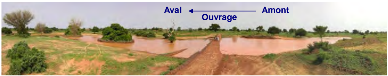
L'ouvrage de retenue d'eau de Tounga Mai Komso (de type seuil d'épandage) dans la région de Dosso, photographié en août 2006
