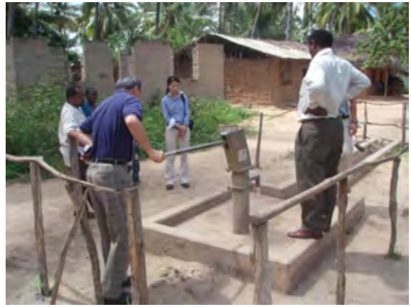
使用時のみロックを開錠して使用するハンドポンプ
