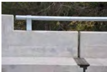
鋼製高欄(歩道側)
