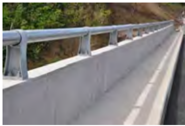
鋼製高欄(歩道側)
