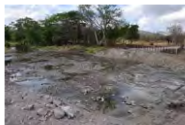
迂回路(撤去完了)
