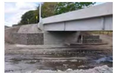
A1 橋台と護岸工
