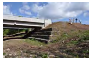
A2 橋台護岸工
