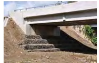
A1 橋台護岸工
