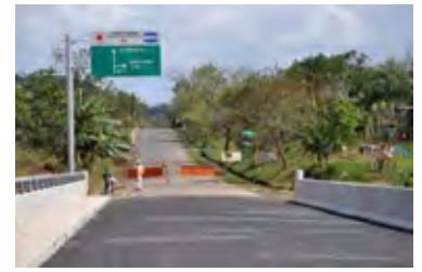
案内標識(起点側から)
