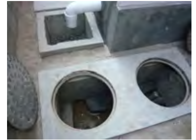
021 雨水マンホール
