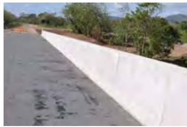
壁高欄(車道側)
