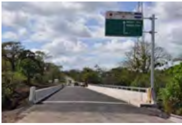
ムアン橋と案内標識
