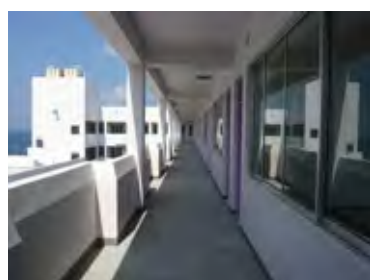
005 特別教室棟廊下
