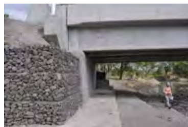
A1 橋台側面
