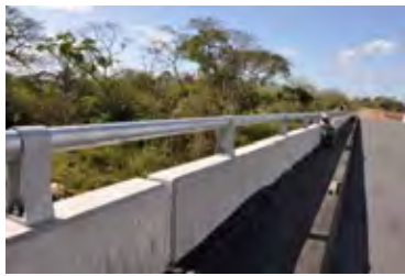
鋼製高欄(歩道側)
