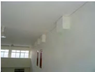
043 鉄骨トラスを支える コンクリートアゴ 1
