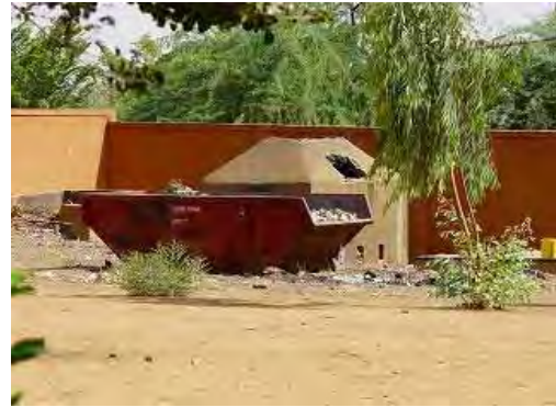
DS 医療廃棄物処理用の焼却炉
