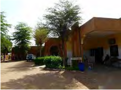
DS 管理棟建物外観
