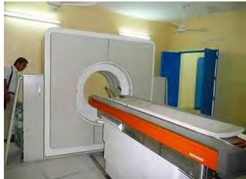
ラモルデ国立病院 主要機材がほとんど稼働していない
