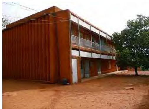
ENSP 看護実習訓練用建物外観
