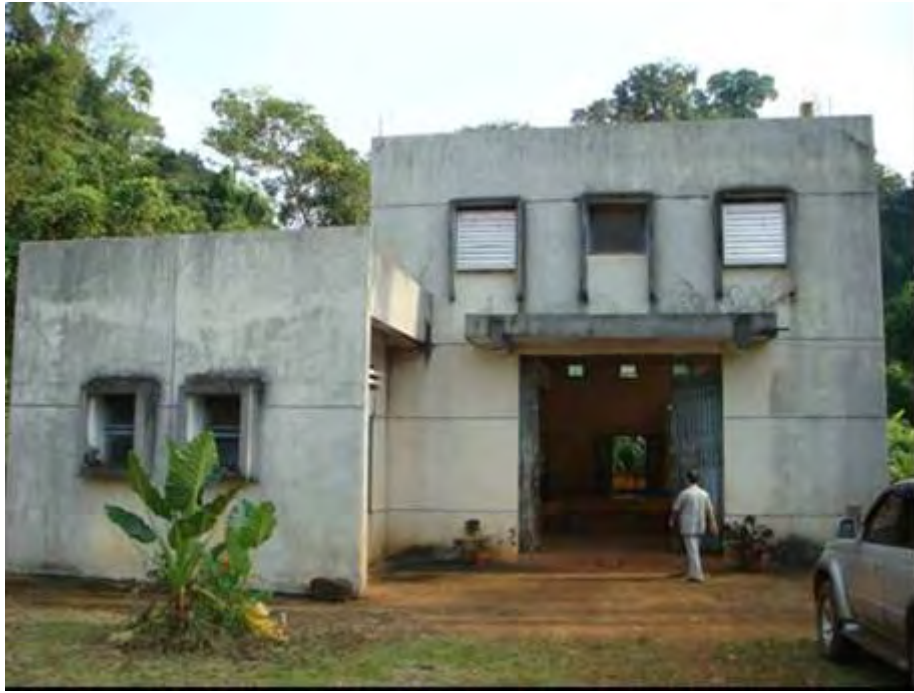
Photo 5.2-5 O'chum 2 発電所外観
