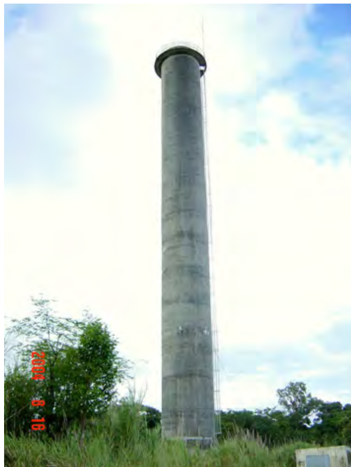
Photo 5.3-5 Kirirom 1 発電所のタワー型サージタンク (写真は 2004 年 8 月 16 日撮影のもの)
