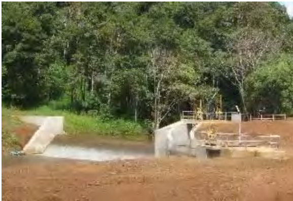
Photo 5.4-3 取水堰および沈砂池 (O'Romis 水力計画)
