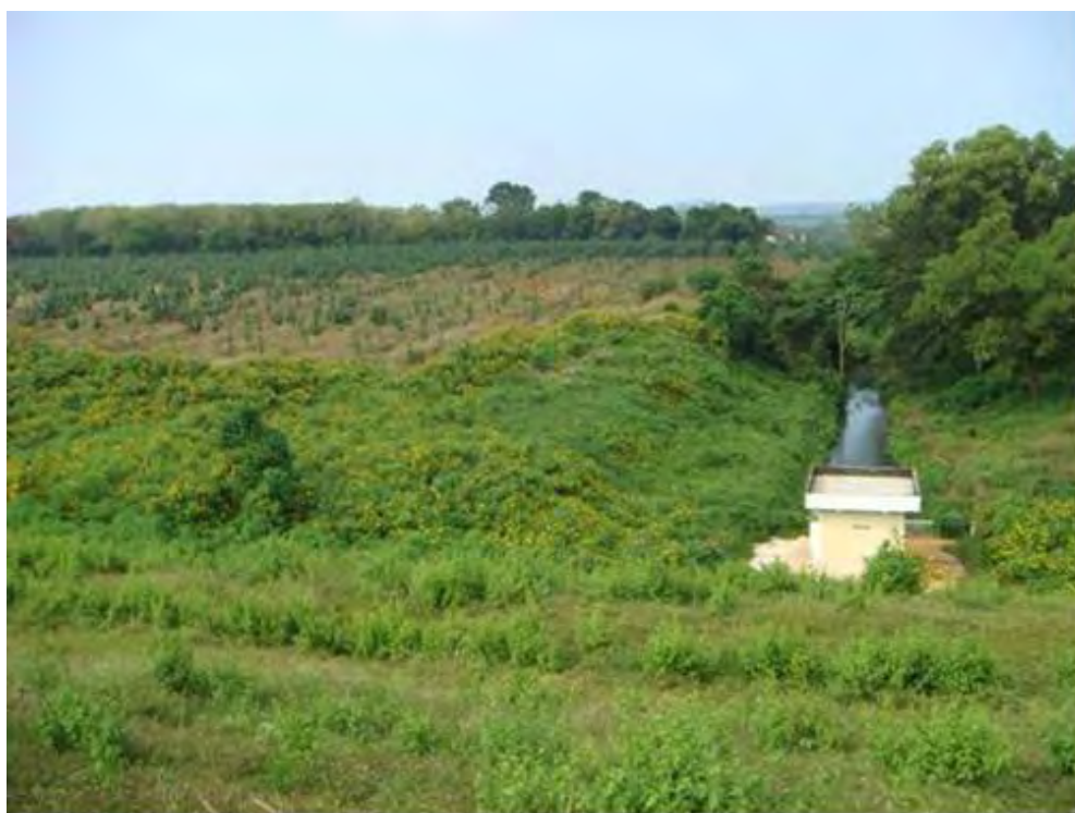
Photo 5.2-2 O'Chum 1 ダム 下流減勢バルブ室および O'Chum 2 ダムへの開水路
