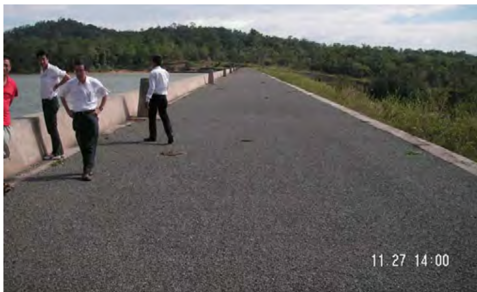
Photo 5.3-2 Kirirom 1 発電所ダムの天端(2/2)
