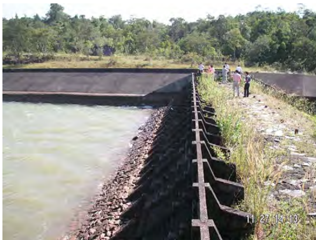
Photo 5.3-4 Kirirom 1 発電所ダムのヒューズプラグ型非常用洪水吐(左岸側)
