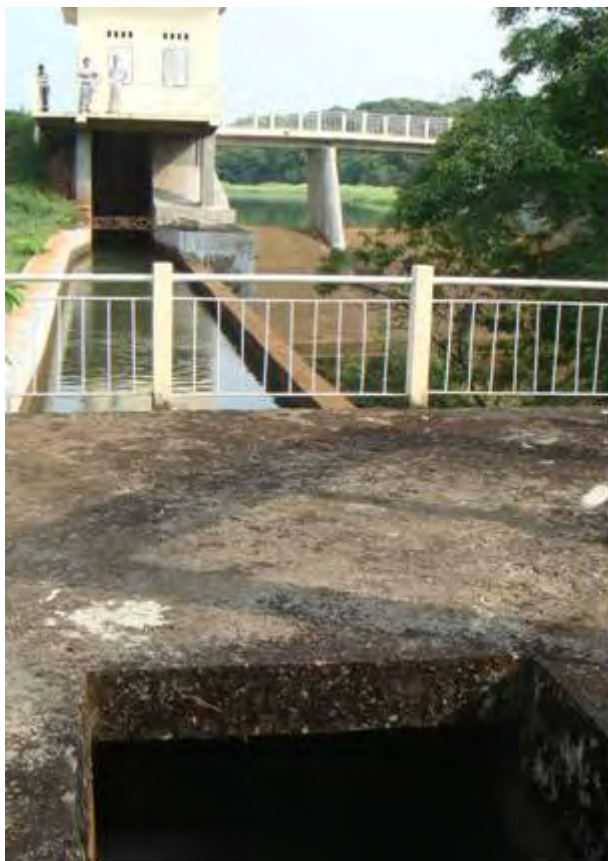
Photo 5.2-3 沈砂池下流端から上流の取水口、 O'Chum 2 ダム洪水吐きをのぞむ
