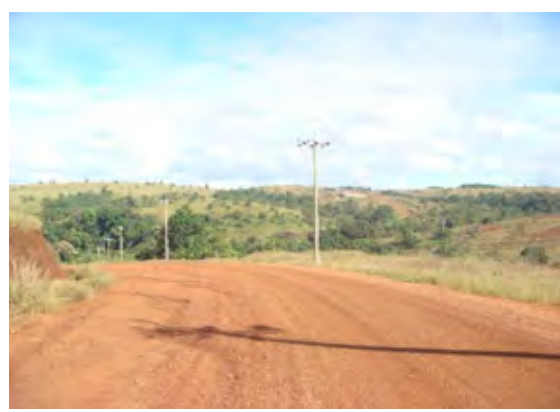
Photo 5.4-6 Mondul Kiri プロジェクト 送配電線
