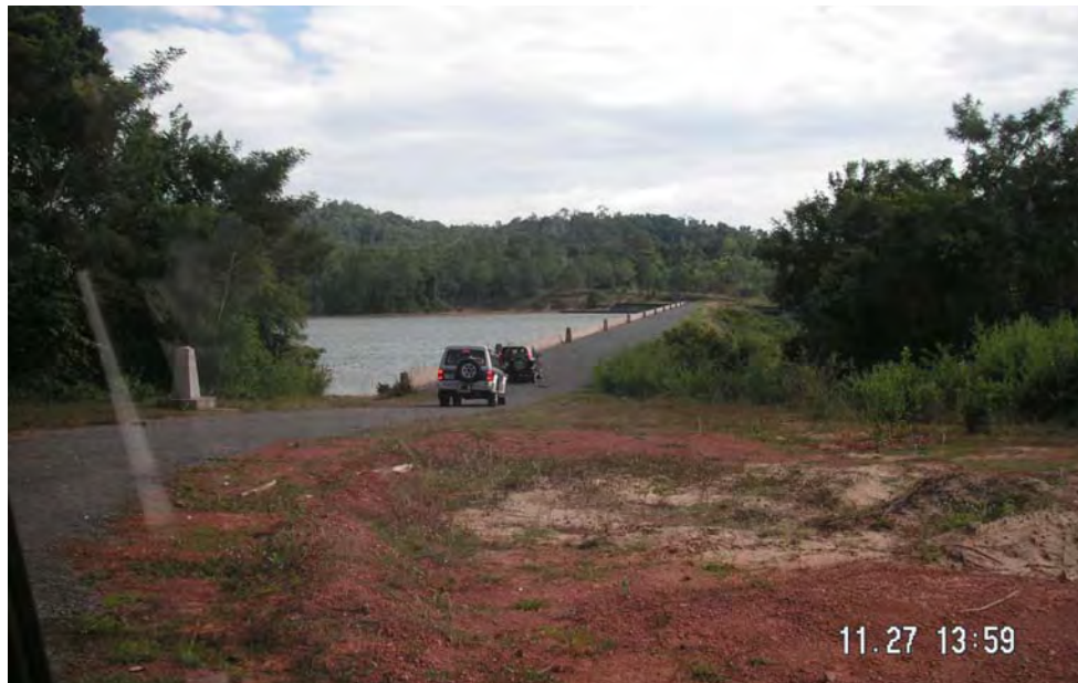
Photo 5.3-1 Kirirom 1 発電所ダムの天端(1/2)
