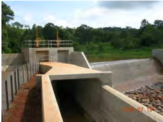
Photo 5.4-1 取水堰および沈砂池 (O'Moleng 水力発電計画)
