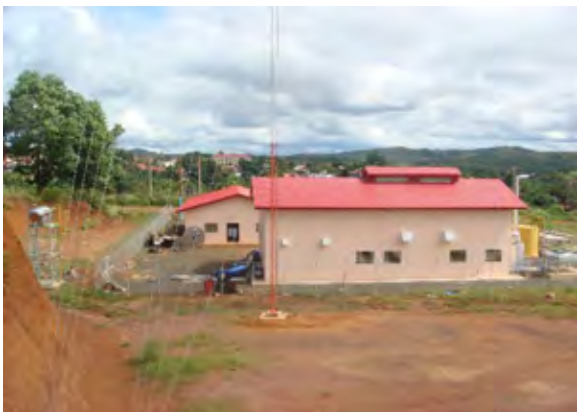
Photo 5.4-5 ディーゼル発電所(手前) および管理棟(左奥)
