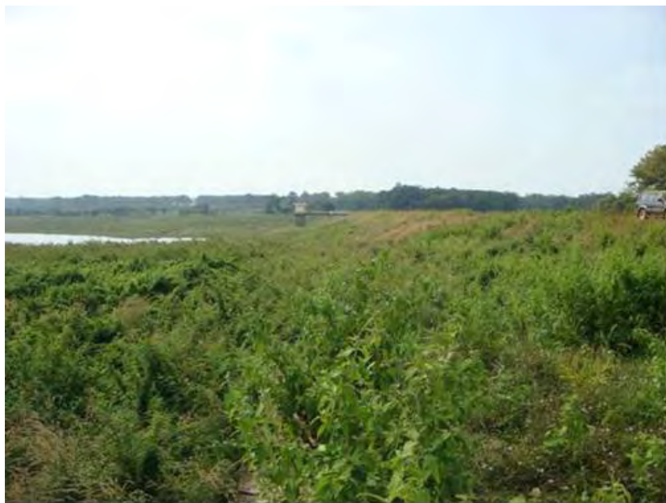
Photo 5.2-1 O'Chum 1 ダム (上部ダム) 上流部および取水塔を右岸からのぞむ
