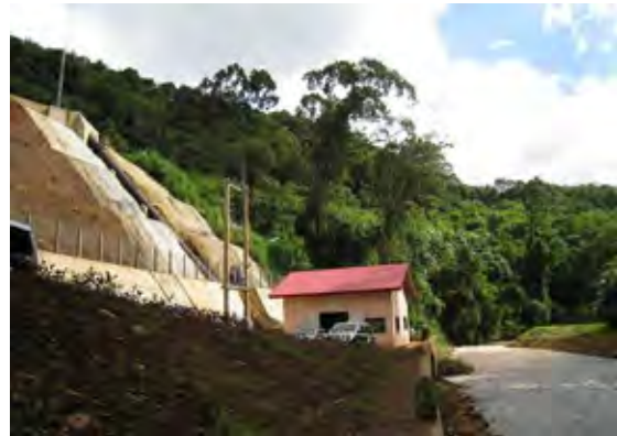
Photo 5.4-4 発電所 (O'Romis 水力計画)
