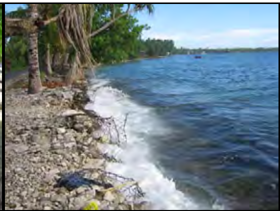
写真 4 - 22 高潮時の蛇籠による護岸工
