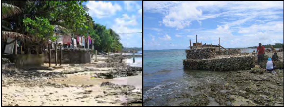
写真 4-41 海岸部の埋立地の状況
