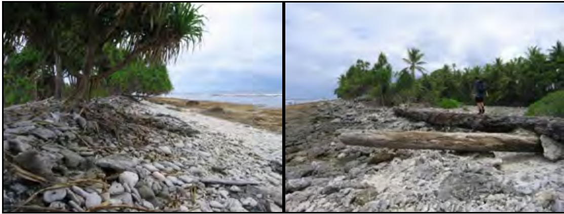
写真 4-1 外洋側の海岸の状況
