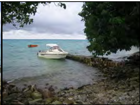
写真 4 - 38 私設の船着き場の状況
