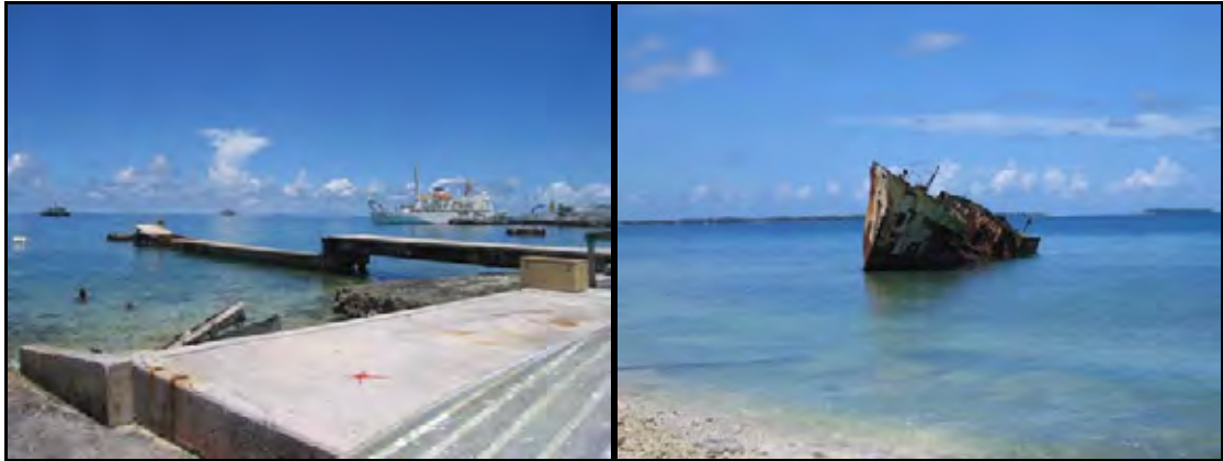
写真 4 - 25 フナフチ港南側の漁港棧橋
