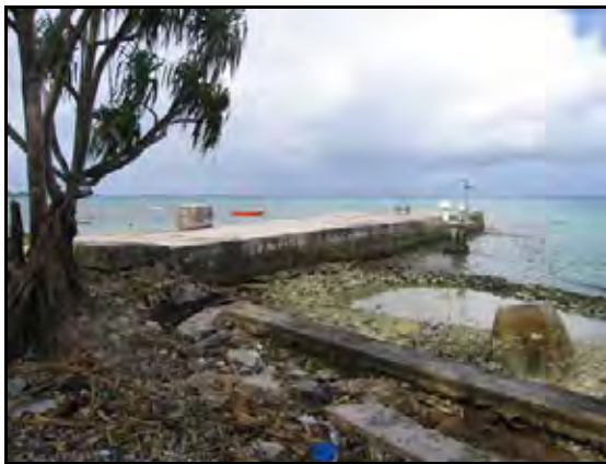
写真 4 - 37 政府庁舎裏の旧岸壁の状況
