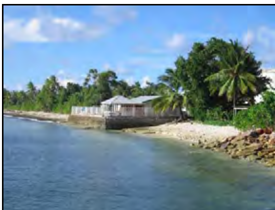
写真 4 - 23 フナフチ港北側の埋立地
