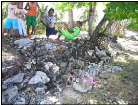
写真 4 - 21 低潮時の蛇籠による護岸工
