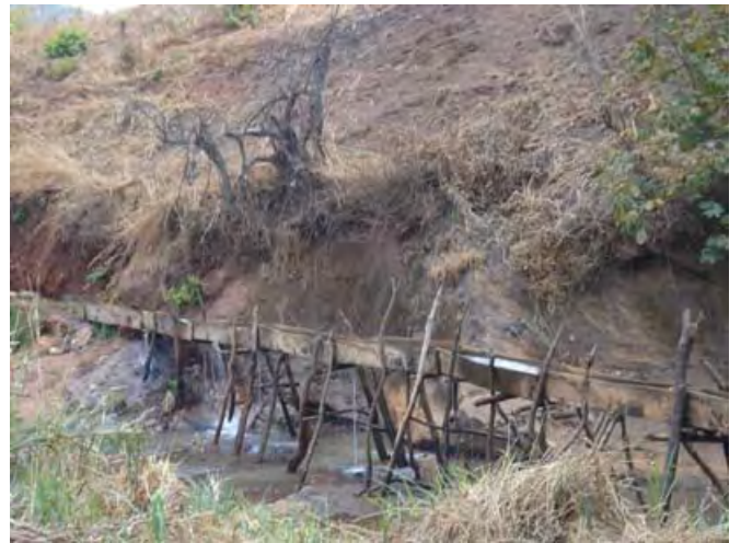
木材とビニールシートを利用して建設 された水路橋 (灌漑開発コンポーネント)
