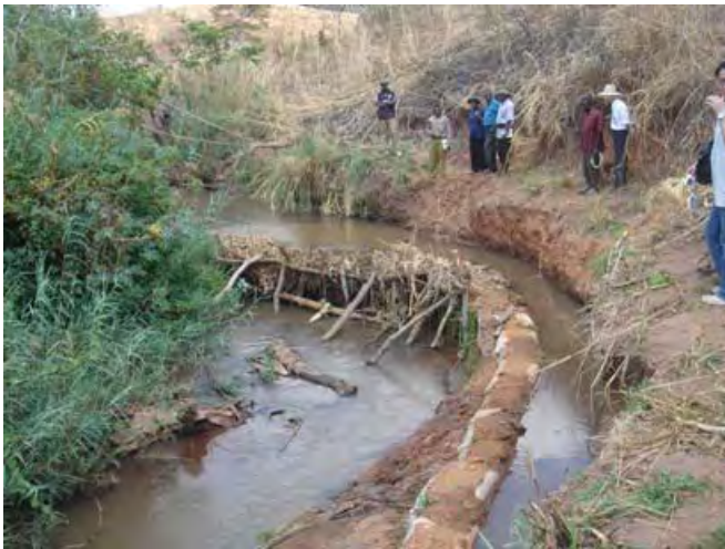
木・草・粘土を利用して建設された 取水堰 (灌漑開発コンポーネント)
