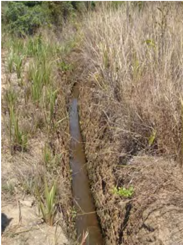
地面を掘削して作られた水路 (灌漑開発コンポーネント)
