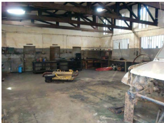
写真 13 (2009/04/15) 撮影 EPAR-Gaza のワークショップの内部の様子。工具はほとんどなく、簡単な修理のみを行っている。
