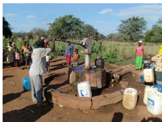
写真 16 (2009/04/16) 撮影 周囲の井戸が全て故障しているため、この井戸にのみ頼って住民が集中してしまい混みあっている（マプト州）。
