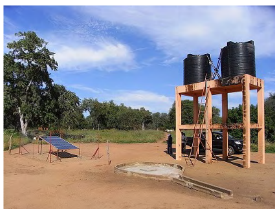
写真 15 (2009/04/16) 撮影 1 年前に新設された太陽光給水設備。郡庁が管理しており、維持管理は現在のところされているが、徴収料金は極端に少ない（ガザ州）。
