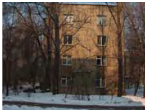
Рис. Ме-2/22. Жилое здание, пр. Достык, 103
