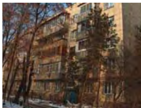
Рис. Ме-2/21. Жилое здание, пр. Достык, 103/40
