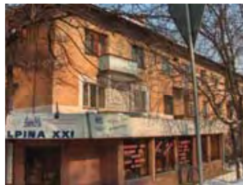
Рис. Ме-2/26. Жилое здание, пр. Достык, 278
