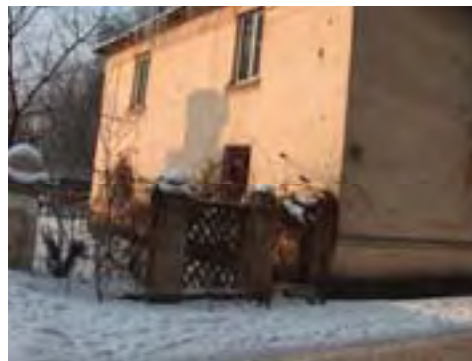
Рис. Ту-1/12. Жилое здание, ул.Р. Зорге, 15
