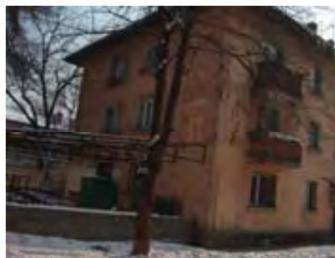
Рис. Ту-1/9. Жилое здание, ул.Р. Зорге, 5
