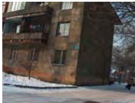
Рис. Ту-1/10. Жилое здание, ул.Л. Толстого, 5
