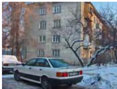
Рис. Ме-2/6. Жилое здание, ул. Фурманова, 274
