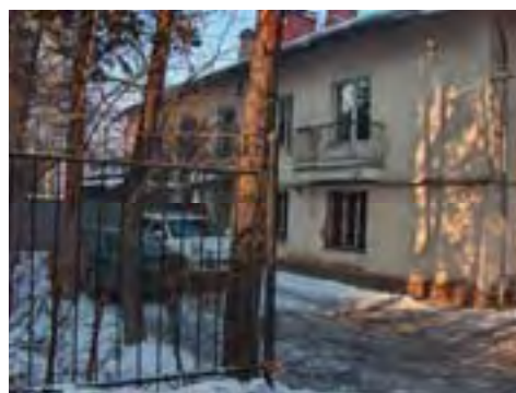
Рис. Ме-2/11. Жилое здание, ул. Х. Мукана, 36
