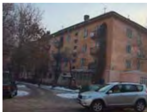
Рис. Ме-2/1. Жилое здание, ул. Фурманова, 264
