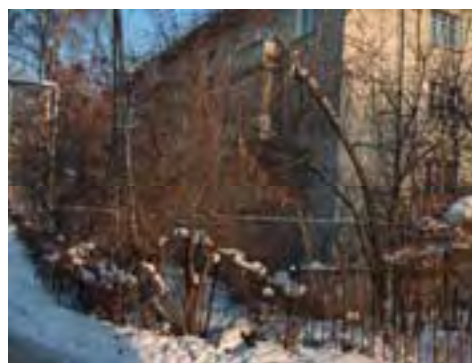
Рис. Ме-2/5. Жилое здание, ул. Фурманова, 272
