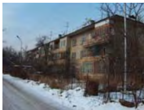
Рис. Ту-2/20. Жилое здание, ул. Кронштадская, 18а
