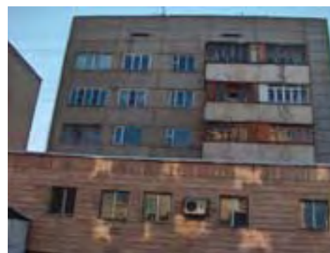
Рис. Аи-1/7. Жилое здание, м-он «Жетысу-3», 51
