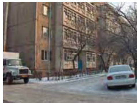
Рис. Ту-1/8. Жилое здание, ул. Сауранбаева, 2
