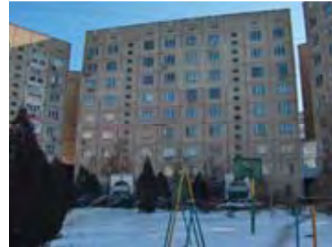
Рис. Аи-1/3. Жилое здание, м-он «Жетысу-2», 46
