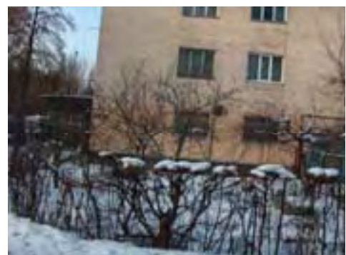
Рис. Ту-2/6. Жилое здание, ул. Огарева, 2в
