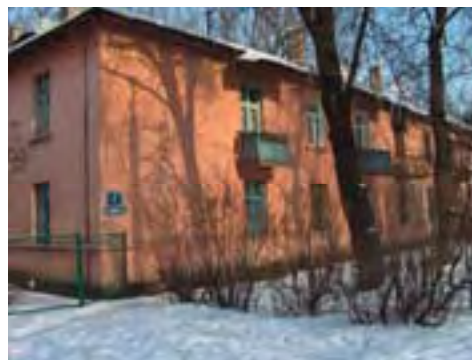
Рис. Ту-2/18. Жилое здание, ул. Майлина, 7
