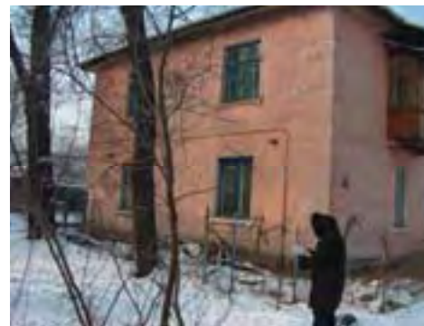
Рис. Ту-1/2. Жилое здание, ул. Чернышевского, 24
