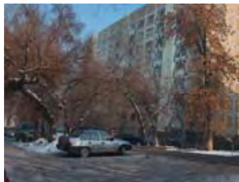
Рис. Ме-2/16. Жилое здание, ул. С. Байжанова, 10
