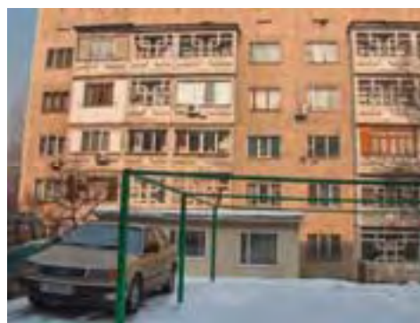
Рис. Ме-2/23. Жилое здание, пр. Достык, 113
