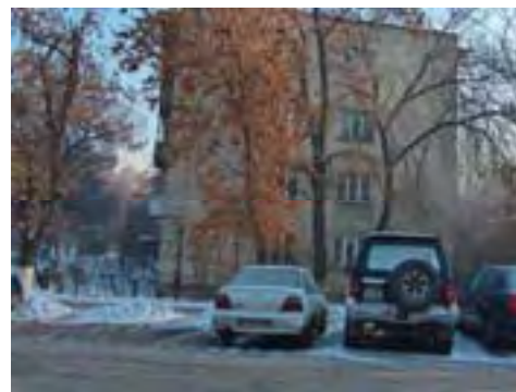
Рис. Ме-2/2. Жилое здание, ул. Фурманова, 266
