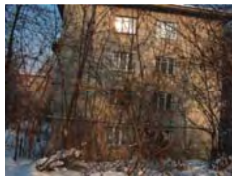
Рис. Ме-2/3. Жилое здание, ул. Фурманова, 268
