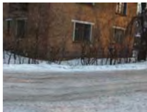
Рис. ТИ-1/5. Жилое здание, ул. Сейфуллина, 16а
