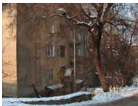
Рис. Ме-2/27. Жилое здание, пр. Достык, 276
