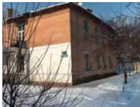
Рис. Ту-2/17. Жилое здание, ул. Майлина, 5
