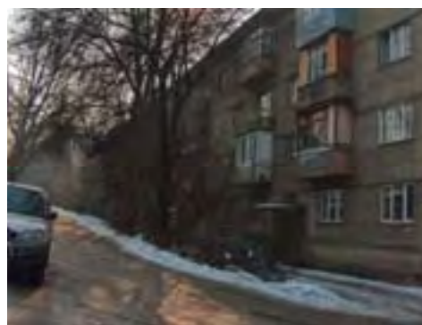
Рис. Ме-2/29. Жилое здание, ул. Елебекова, 27
