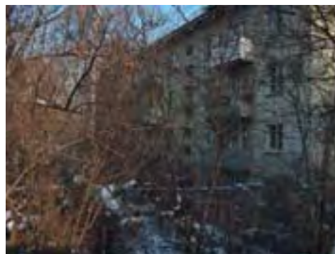
Рис. Ме-2/8. Жилое здание, ул. Фурманова, 278
