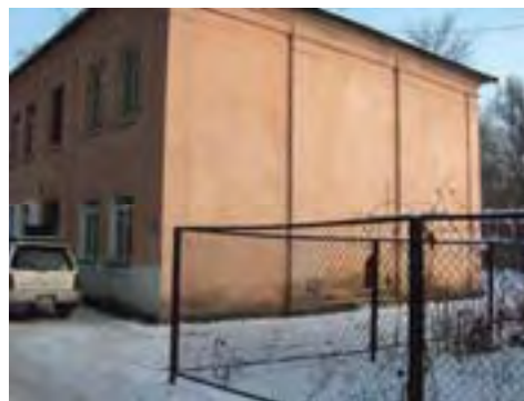
Рис. Ту-2/9. Жилое здание, ул. Огарева, 1
