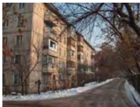
Рис. Ме-2/19. Жилое здание, пр. Достык, 107/3
