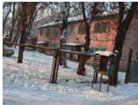
Рис. Tu-1/4. Жилое здание, ул. Сейфуллина, 18
