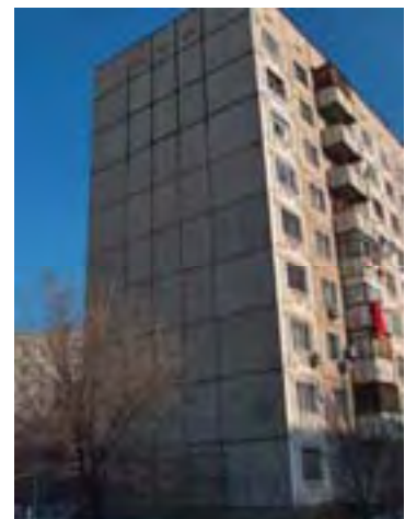
Рис. Аи-1/4. Жилое здание, м-он «Жетысу-2», 52
