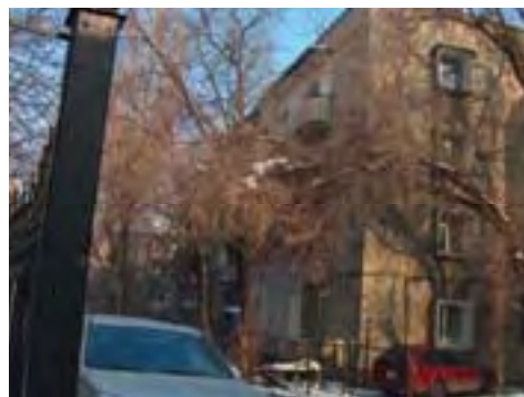
Рис. Ме-2/12. Жилое здание, ул. Х. Мукана, 18/1
