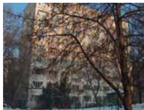
Рис. Ме-2/17. Жилое здание, пр. Достык, 105/2
