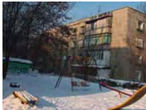
Рис. Ме-2/14. Жилое здание, ул. Х. Мукана, 18/2
