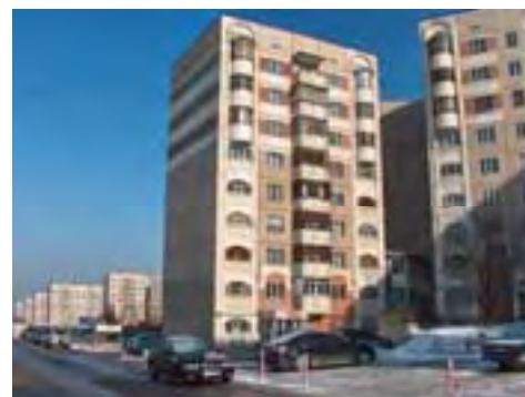
Рис. Аи-1/6. Жилое здание, м-он «Жетысу-2», 77
