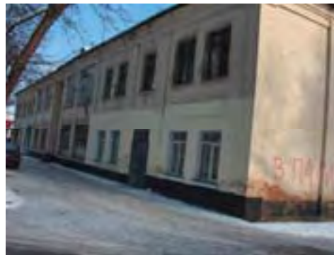
Рис. Ту-2/10. Жилое здание, ул. Огарева, 5
