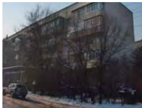
Рис. Ме-2/20. Жилое здание, пр. Достык, 111/4
