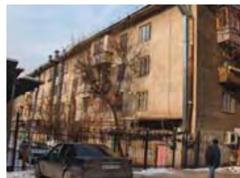
Рис. Ме-1/76. Жилое здание, ул. Кунаева, 97
