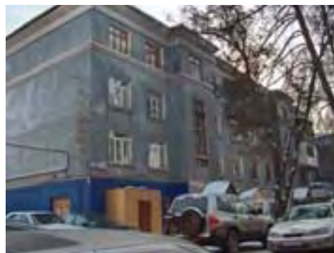
Рис. Ме-1/73. Жилое здание, ул. Фурманова, 120
