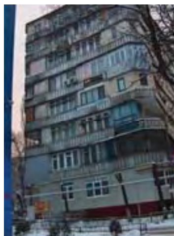
Рис. Zh-1/48. Жилое здание, ул. Панфилова, 80
