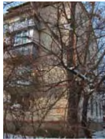
Рис. ВО-1/14. Жилое здание, ул. Айманова, 195а
