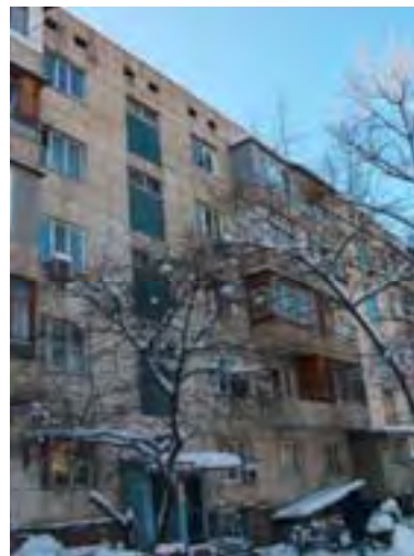
Рис. AL-2/17. Жилое здание, ул. Курмангазы, 171
