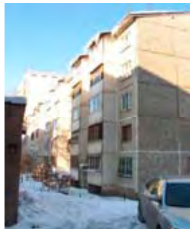
Рис. AL-2/19. Жилое здание, ул. Курмангазы, 177
