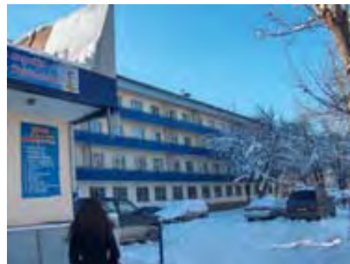
Рис. AL-2/11. Жилое здание, ул. Курмангазы, 150
