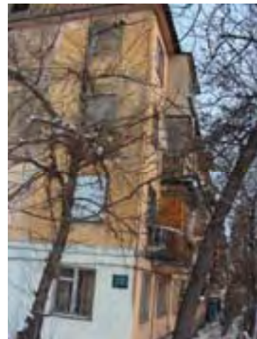
Рис. ВО-1/30. Жилое здание, ул. Розыбакиева, 206
