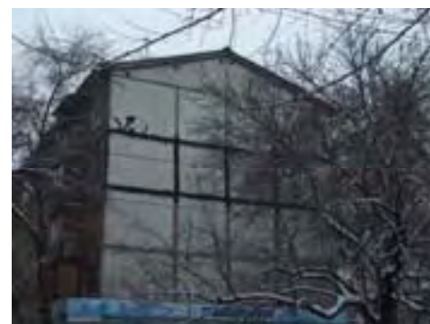
Рис. Zh-1/42. Жилое здание, ул. Наурызбай батыра, 28
