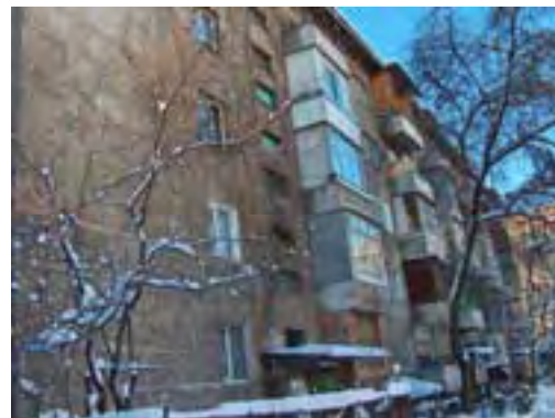
Рис. AL-2/8. Жилое здание, ул. Шевченко, 166А
