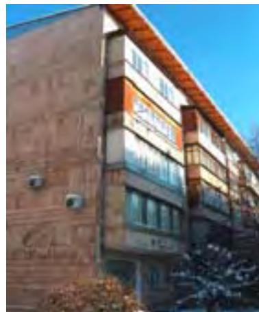
Рис. AL-2/18. Жилое здание, ул. Курмангазы, 173
