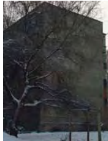
Рис. AI-1/33. Жилое здание, ул. Мауленова, 54
