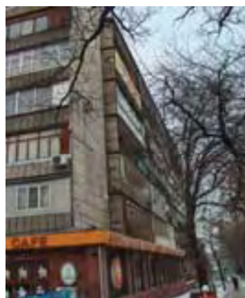
Рис. Zh-1/18. Жилое здание, ул. Наурызбай батыра, 37
