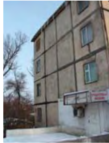
Рис. ВО-1/29. Жилое здание, ул. Розыбакиева, 204
