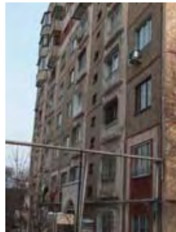
Рис. ВО-1/26. Жилое здание, ул. Радостовца, 152/5
