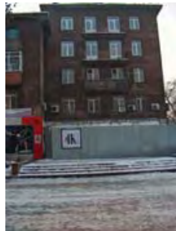
Рис. Zh-1/54. Жилое здание, пр. Абылай Хана, 62
