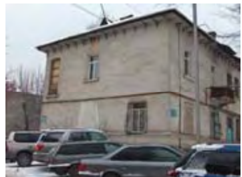
Рис. Zh-1/40. Жилое здание, ул. Торекулова, 64
