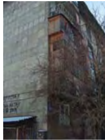
Рис. ВО-1/27. Жилое здание, ул. 16 линия, 184
