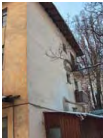
Рис. AI-1/31. Жилое здание, ул. Сейфуллина, 464
