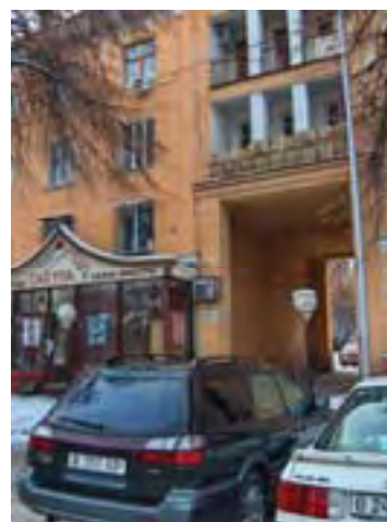
Рис. А1-1/72. Жилое здание, ул. Жамбыла, 48
