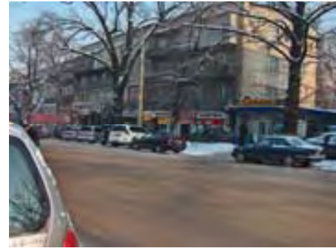
Рис. Zh-1/53. Жилое здание, ул. Желтоксан, 67
