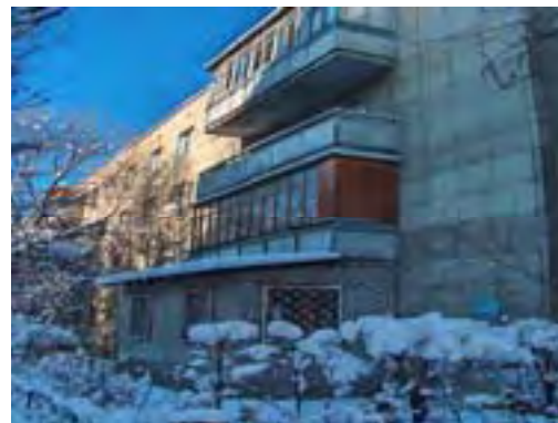
Рис. AL-2/6. Жилое здание, ул. Курмангазы, 153
