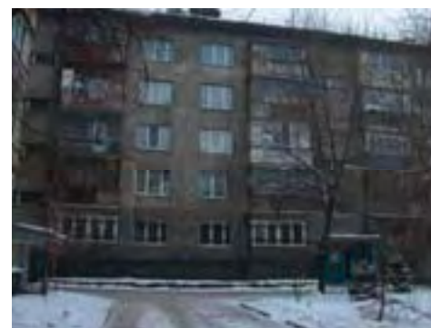
Рис. Ме-1/60. Жилое здание, ул. Кунаева, 161
