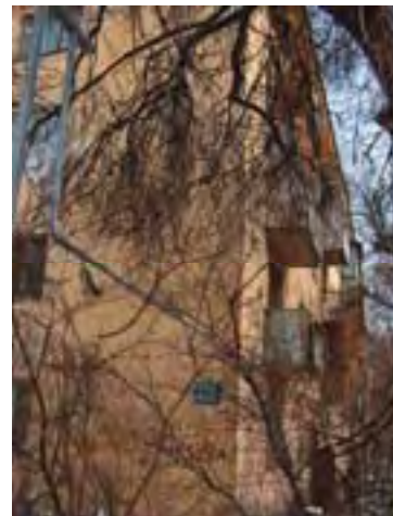
Рис. ВО-1/28. Жилое здание, ул. 16 линия, 188
