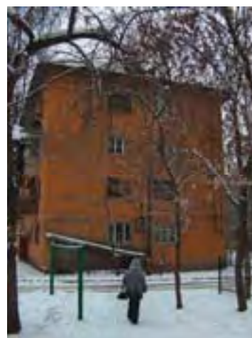
Рис. AI-1/36. Жилое здание, ул. Мауленова, 51
