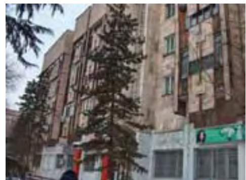
Рис. Zh-1/24. Жилое здание, пр. Сейфулина, 450
