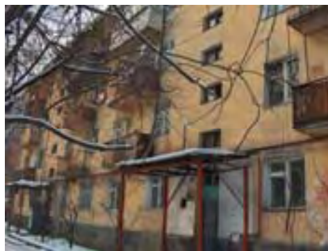
Рис. AI-1/32. Жилое здание, ул. Сейфуллина, 466
