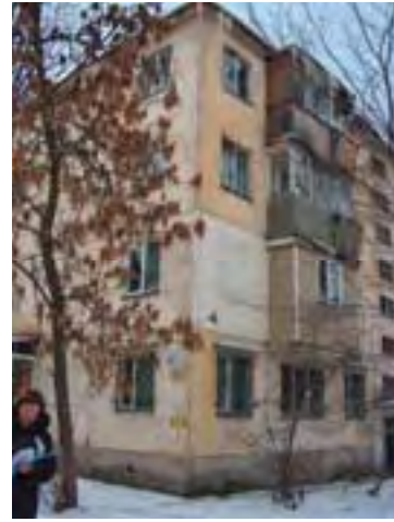
Рис. ВО-1/23. Жилое здание, ул. Радостовца, 193
