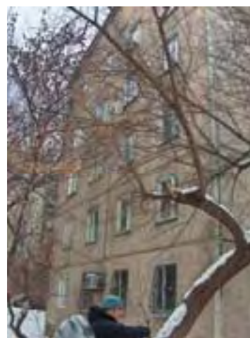
Рис. Zh-1/22. Жилое здание, пр. Сейфулина, 452/3
