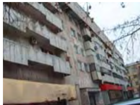
Рис. АІ-1/8. Жилое здание, ул. Толе би, 75
