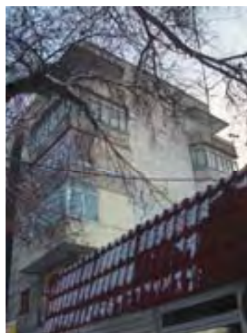
Рис. AI-1/30. Жилое здание, ул. Айтеке би, 100
