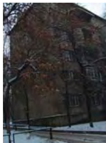
Рис. AI-1/56. Жилое здание, ул. Жамбыла, 66
