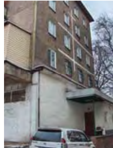
Рис. Zh-1/23. Жилое здание, пр. Сейфулина, 452
