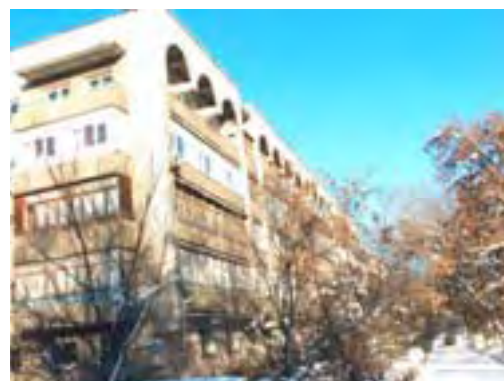
Рис. AL-2/15,16. Жилое здание, ул. Жарокова, 91
