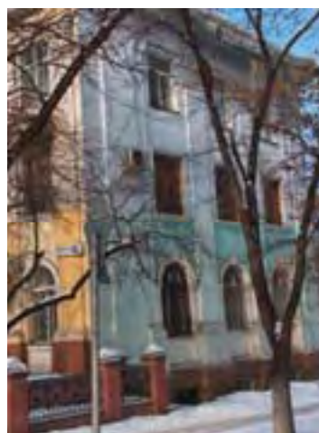
Рис. Ме-1/78. Жилое здание, ул. Толе би, 45
