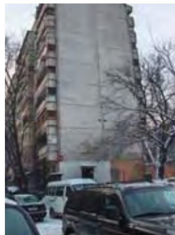
Рис. Zh-1/49. Жилое здание, ул. Торайгырова, 81
