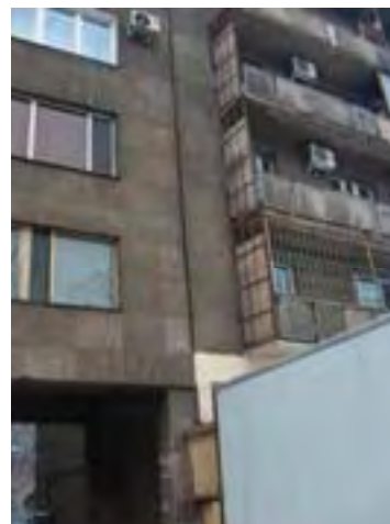
Рис. Ме-1/59. Жилое здание, ул. Кунаева, 153
