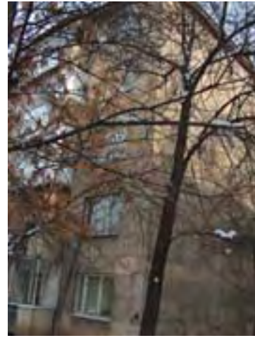
Рис. ВО-1/25. Жилое здание, ул. Радостовца, 152/2
