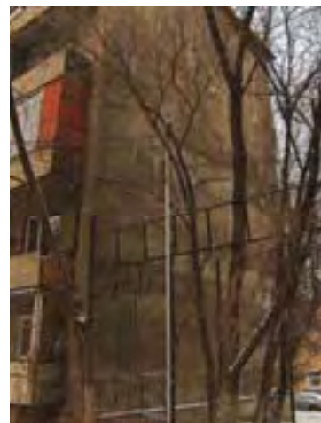
Рис. AI-1/34. Жилое здание, ул. Айтеке би, 98
