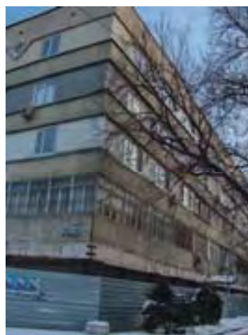
Рис. Ме-1/68. Жилое здание, ул. Фурманова, 148
