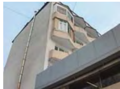
Рис. Zh-1/44. Жилое здание, ул. Макаатаева, 81
