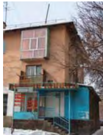
Рис. ВО-1/22. Жилое здание, ул. Радостовца, 201
