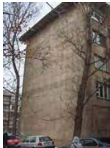
Рис. Zh-1/21. Жилое здание, ул. Жибек Жолы, 126 А
