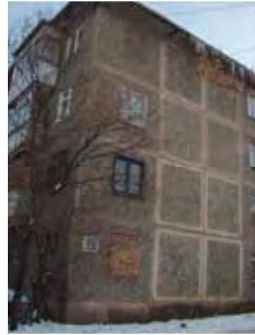
Рис. ВО-1/21. Жилое здание, ул. Радостовца, 152д
