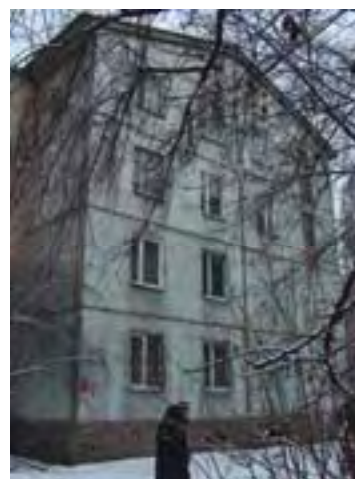
Рис. Zh-1/38. Жилое здание, ул. Наурызбай батыра, 13
