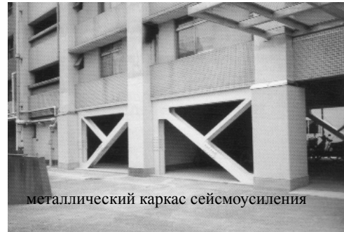
Рис.10 Пример каркаса (рамы) сейсмоусиления (Японии), фото Okazaki (GRIPS, Япония)
