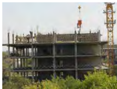
Рис. 2 Строящиеся железобетонные несущие стены
