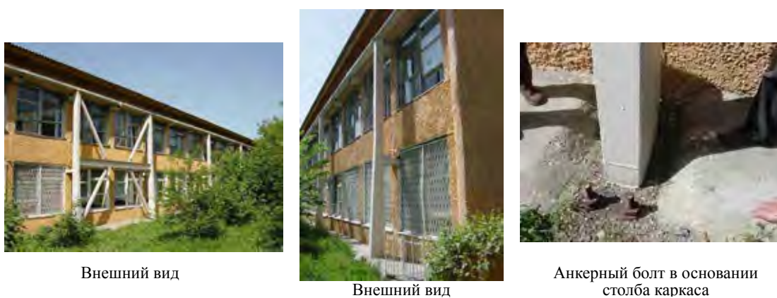
Рис. 1-2 Сейсмоусиление ж/б здания школы KZ-200С
