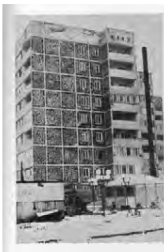
Рис. 6.1.6 Крупнопанельные дома в Ленинакане (левое фото) и Спитаке (правое фото) (EERI, 1)
