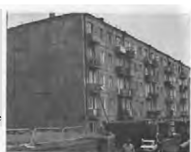
Рис. 6. 28 Пятиэтажное крупнопанельное здание в Спитаке, которое осталось неповреждённым. Оказалось, что это было единственное неповреждённое здание
