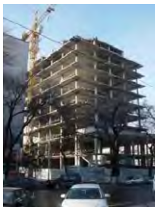
【Категория 8】 Строящийся монолитный дом каркасной конструкции
