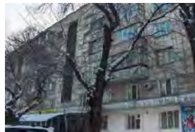
【Категория 6】 Железобетонный каркасный дом (ВТ-20)
