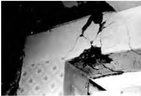
図 6.1.8 梁端部の破壊 (Dr. S. Khakimov による)
