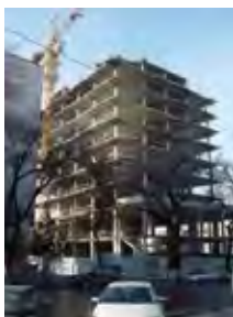
〔分類8〕 RC骨組、工事中のモノリシック
