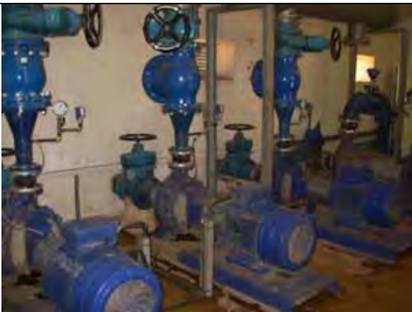
写真-17 ニアメ市内都市給水送水ポンプ室。水開発会社 (SEEN) が運営を請け負っている。商用電力の停電時には給水施設も稼働できず断水となっている。(給水人口約 96 万人)
