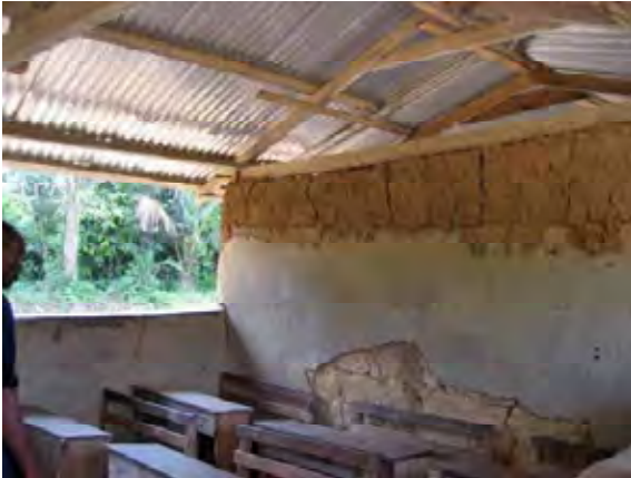
AN1 ベレクニャメベキュレ小学校 土ブロック積壁に亀裂が入り上部の梁の崩壊も危惧される危険校舎
