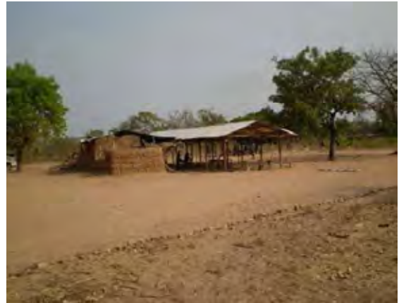
STK 2 ポル小学校 丸木柱造、壁なし状態の教室 左手前は男子小便所部の土製囲い壁
